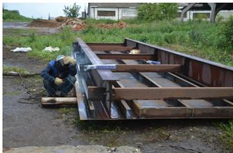
В КФХ «Юлдаш» ведутся работы по монтажу автовесов, способных пропускать автопоезда грузоподъемностью до 150 тонн.
